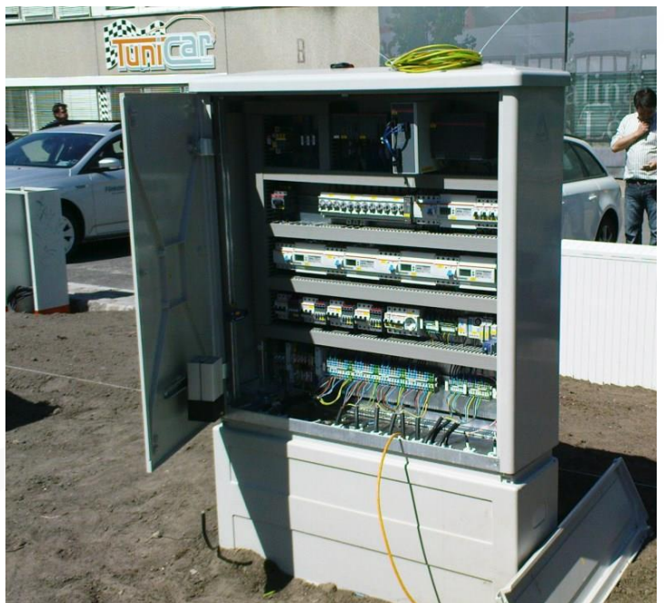
Abbildung 2 Der Energieverteiler
