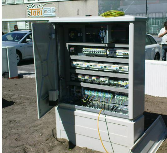
Abbildung 2: Der Energieverteiler
